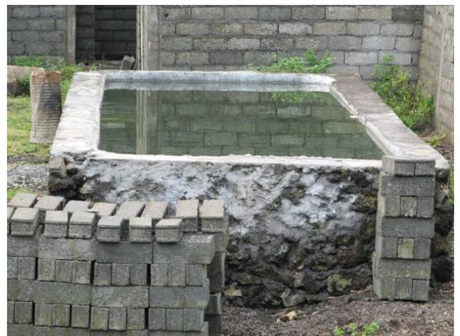
Figure 14 - Installations de récupération des eaux pluviales à la Grande Comore
