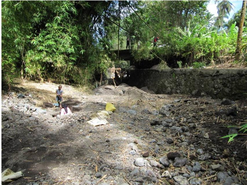
Figure 29 - Evacuation des apports solides à l'amont du franchissement de la route
