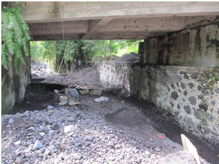
Figure 30 - Evacuation des apports solides au niveau du franchissement de la route
